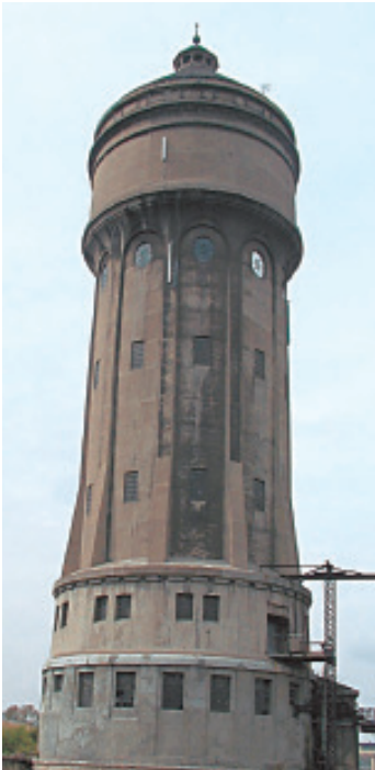
Vor der Sanierung, Südwestansicht
