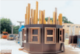
Schalung des Fertigteiltes der Turmlaterne vor Ort
