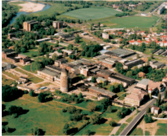
Industrie- und Gewerbegebiet „Kunststoff Center“ am ECW Wasserturm
