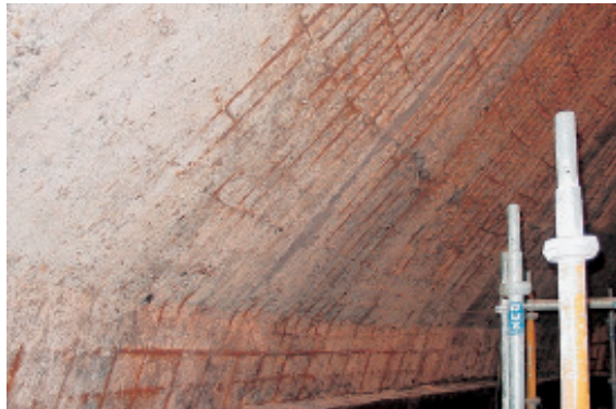
Freiliegende Bewehrung der Dachinnenseite
